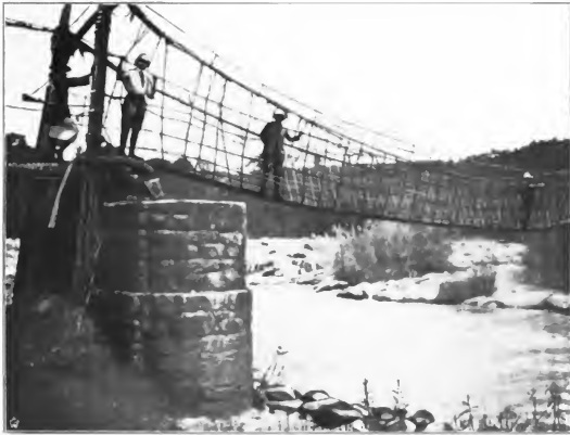
Seilbrücke über den Pangani bei der Pflanzung von Eismann.
